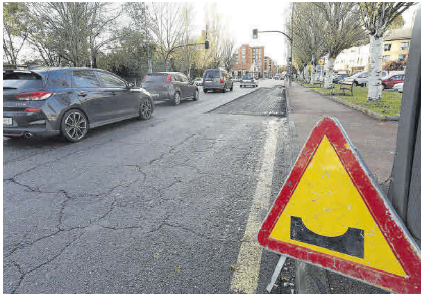
Estado del firme en la calle Gutiérrez Herrero con señalización de obras, ayer por la mañana. | Ricardo Solís
